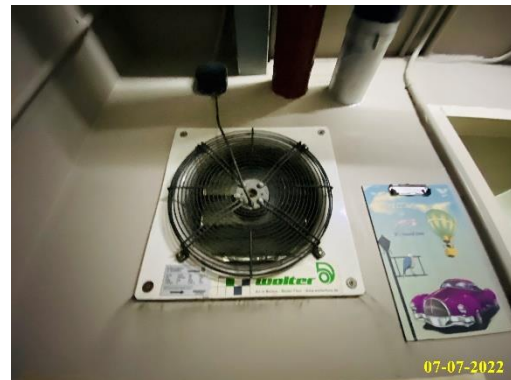
พัดลมระบายอากาศห้องเครื่องไฟฟ้า
